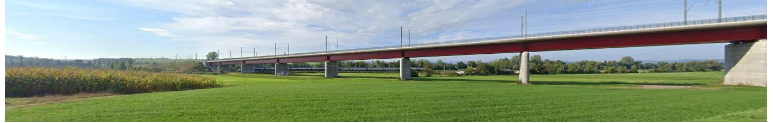
Zornův viadukt u Wilwisheim (délka 453 m) = technické prevence
