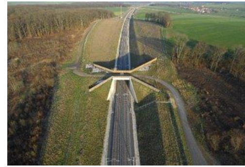
Křížení smíšených velkých živočichů: redukce technickou úpravou
