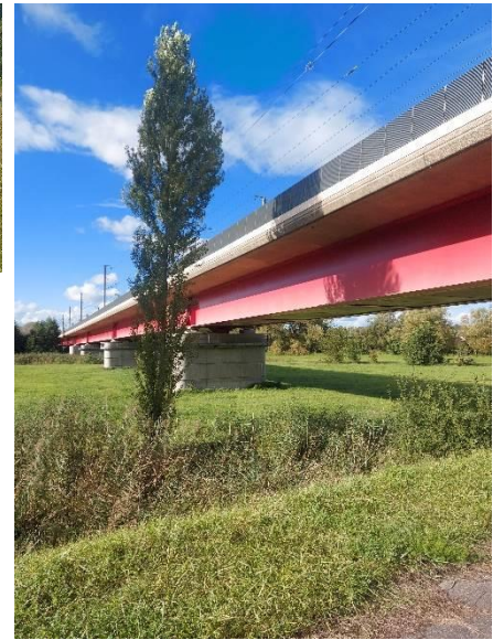
Viadukt Wilwisheim (PK 386)
